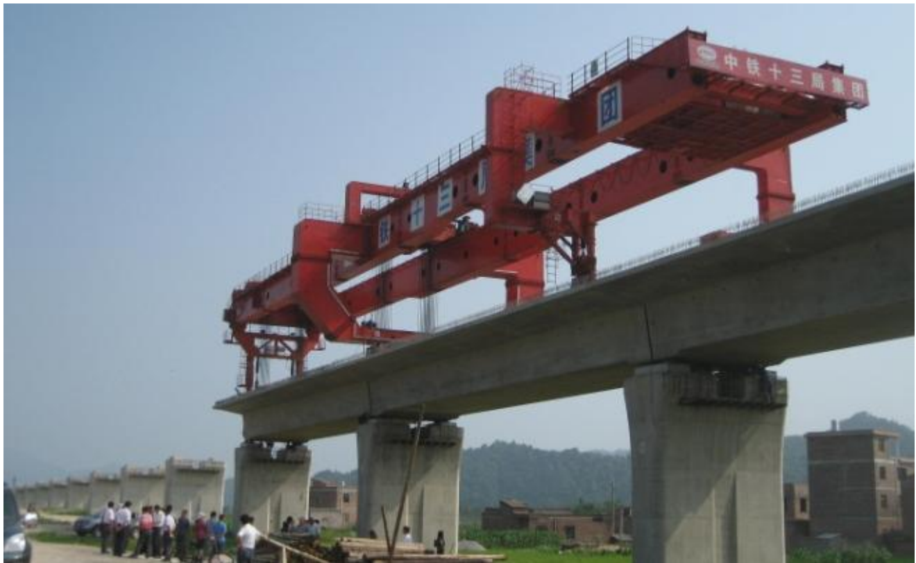
Фото 2. Встановлювач мостових прольотів
